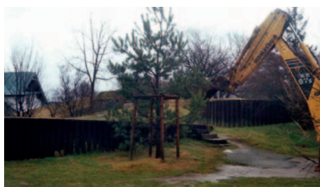
Odpaliště č. 4 krátce před rekonstrukcí...
